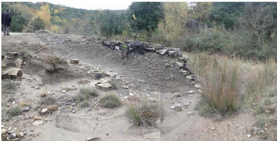
**Figure 83 : Vue sur l'intérieur du bassin de décantation dont une partie du mur de retenue s'est effondrée.**
