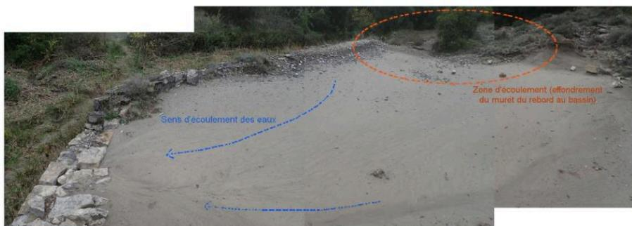
**Figure 82 : Bassin de décantation et son contenu en résidus de traitement fins et limoneux largement raviné par les eaux de ruissèlement**
