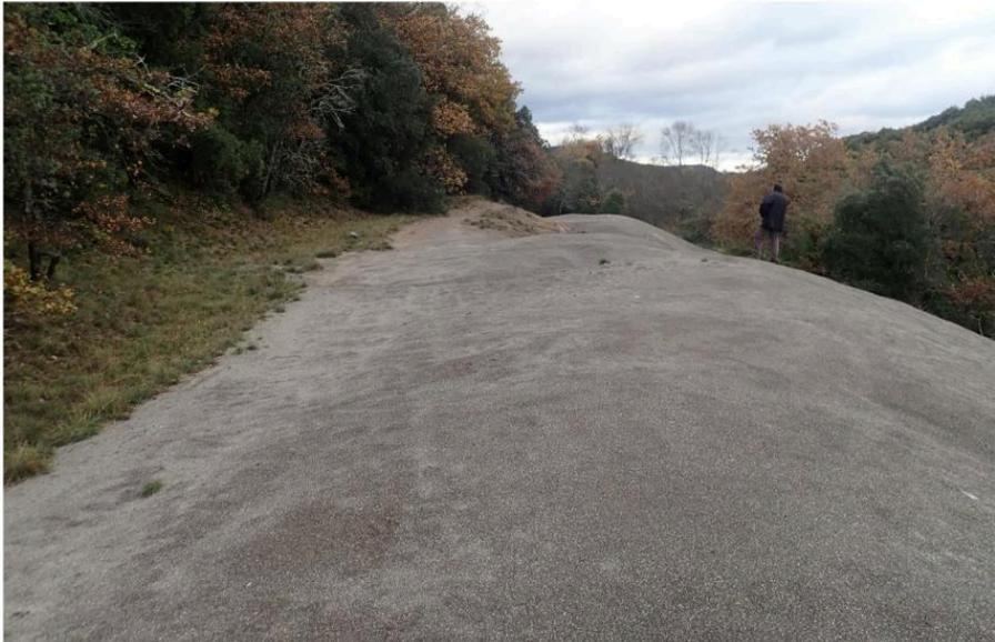
**Figure 86 : Vue sur le haut de la digue à stériles. Un canal de conduite des eaux de pluie peut être aménagé sur le sommet de la digue pour éviter le ravinement de la digue**
