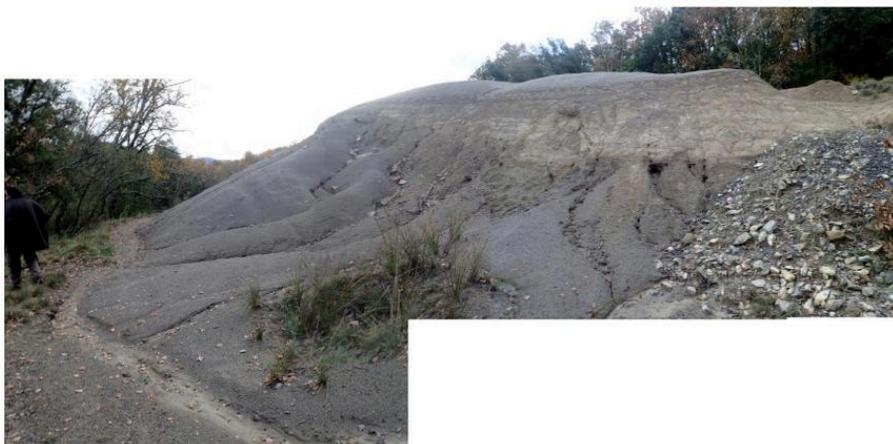
**Figure 85 : Vue des résidus encore en place et fortement ravinés dans la « digue à stériles »**
